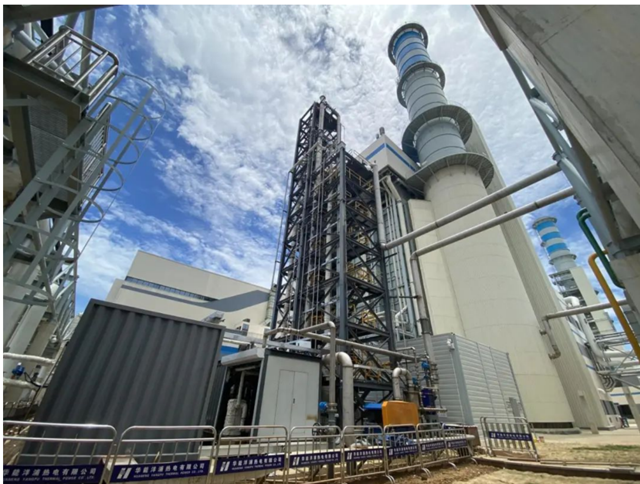
海南省华能洋浦电厂天然气电厂碳捕集示范项目（捕集能力 2000 吨 / 年）（图片来源：华能集团）
