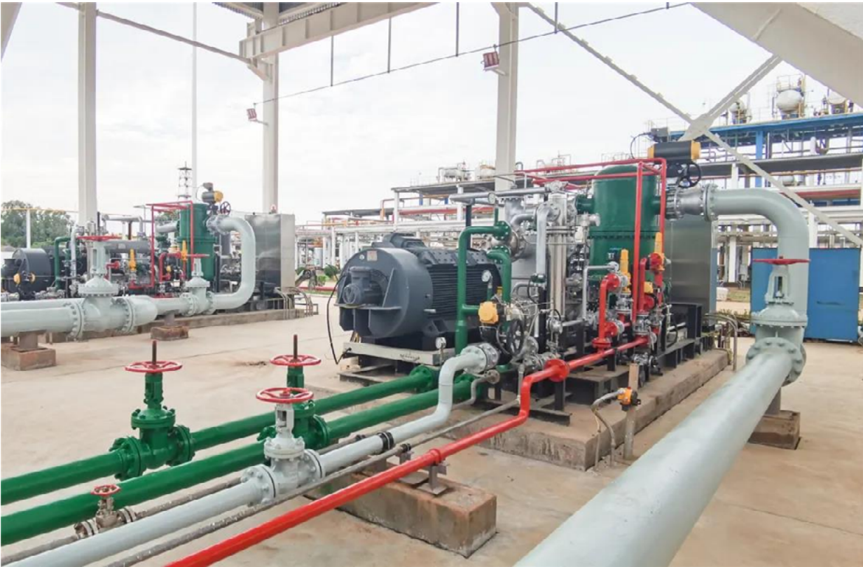
海南福山油田的二氧化碳压缩机。天然气通过分子筛和吸附塔进行脱水处理，随后气体中的二氧化碳被加压并冷凝成液态，用于地下地质封存及提高采油效率。（图片来源：中国船舶重工集团有限公司）
