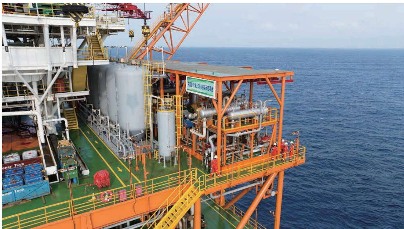
恩平 15-1 油田平台上的 CO 2 处理回注模块，广东珠江口盆地（照片来源：中国海油）。
