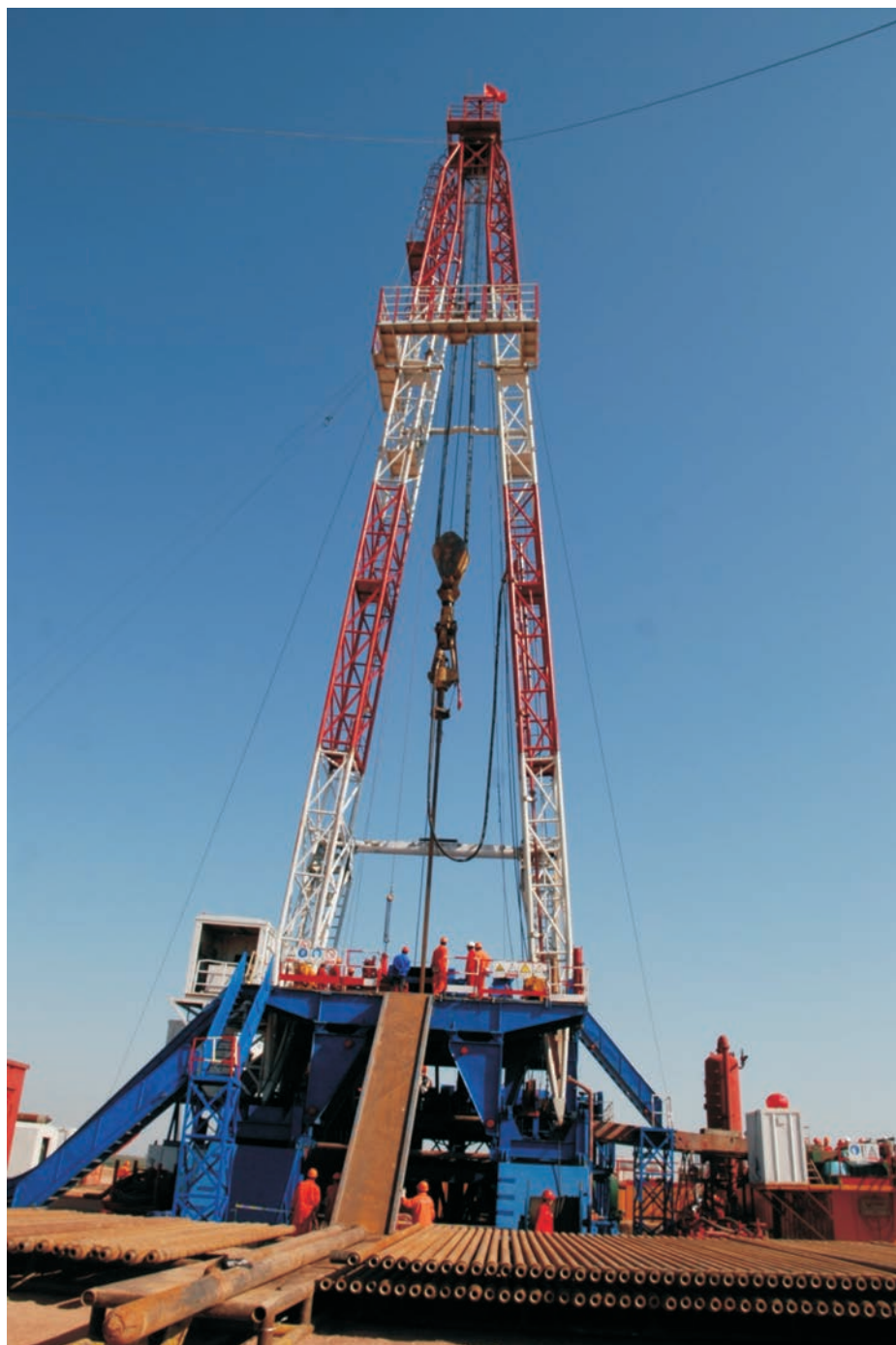
神华二氧化碳钻井施工现场
