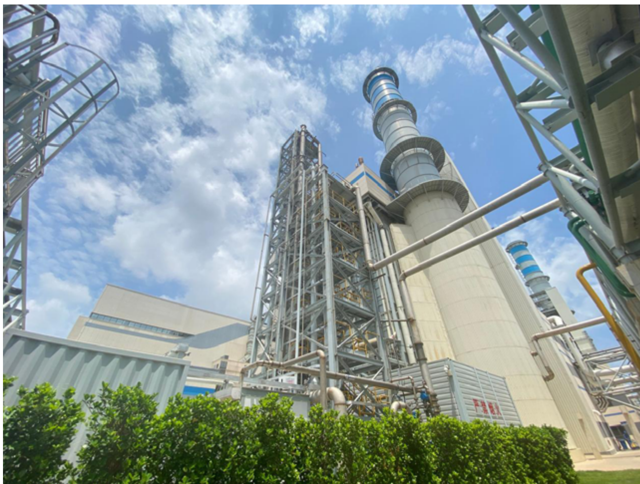
图 11 华能洋浦燃气电厂碳捕集国际测试平台
